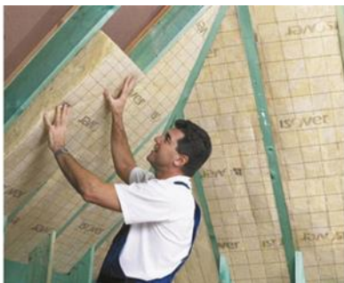
Plaatsing van dakisolatie met lambda-waarde 0,035 W/mK
