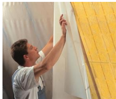
Aanbrengen van een dampscherm
