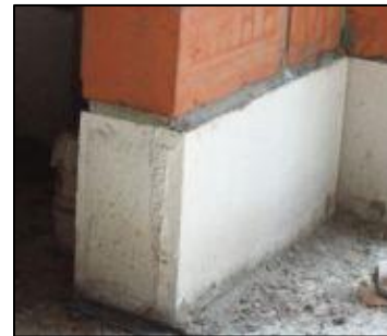
Aanzet binnenspouwblad op vloerplaat met Kimblok
