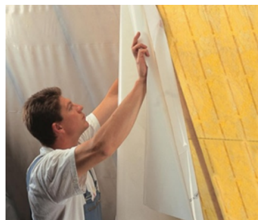
Aanbrengen van een dampscherm
