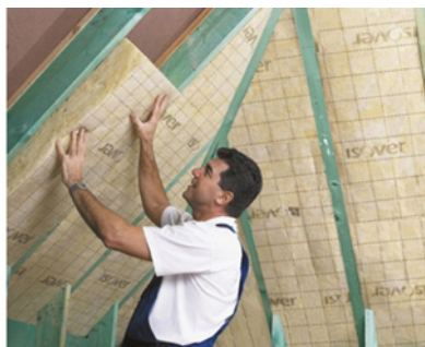
Plaatsing van dakisolatie met lambda-waarde 0,035 W/mK
